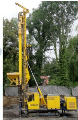
Fig:10 Vibro Stone Columns
